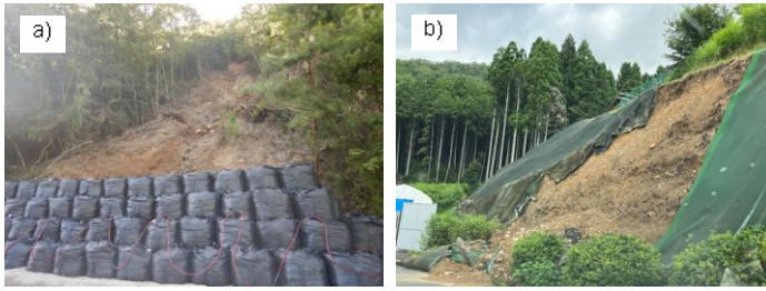
写真-1 「令和4年7月3日からの大雨」により京丹波町内で発生した土砂災害の状況、a) 鎌谷中地区、b) 質美地区
